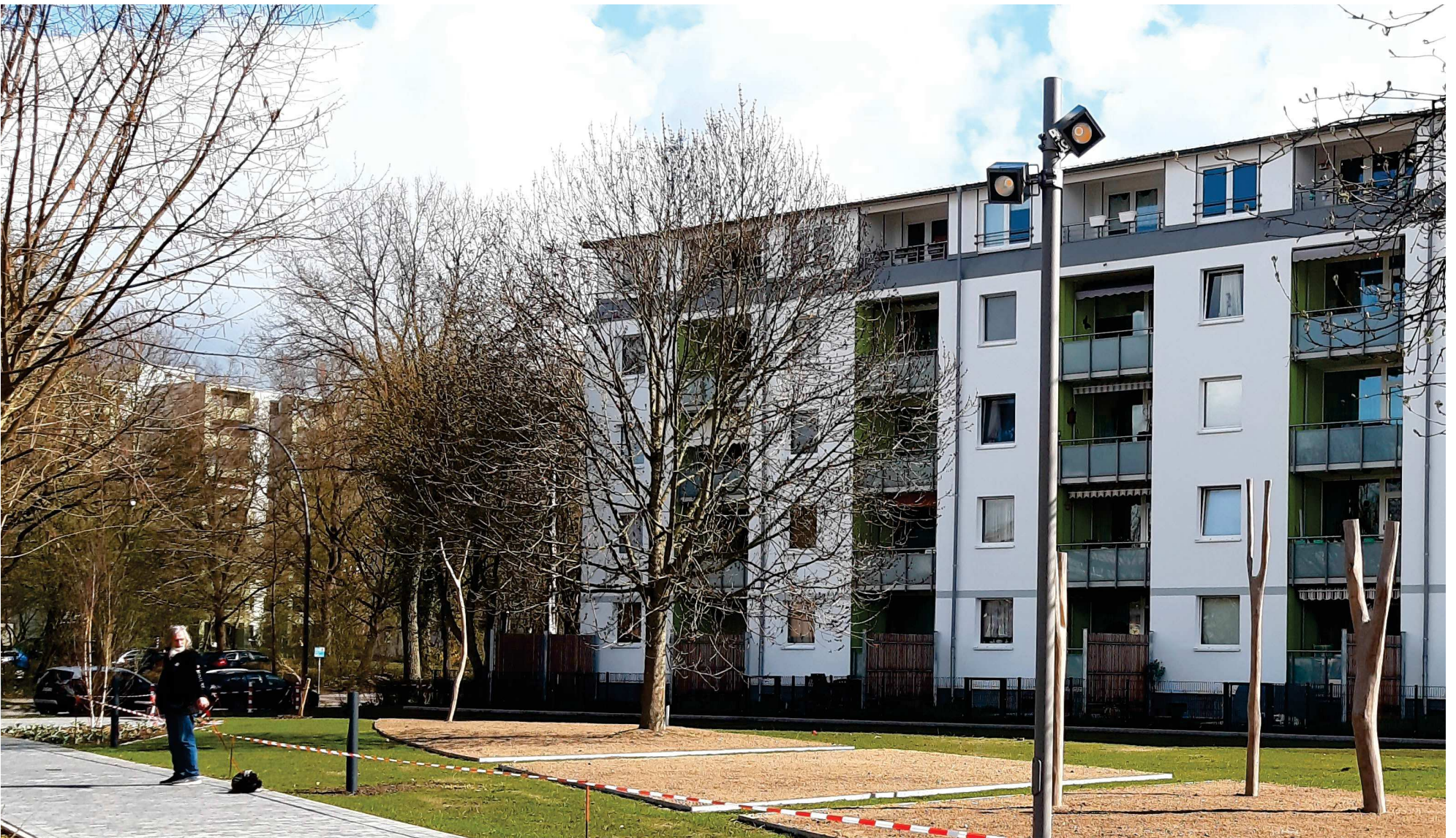
Mastleuchte für den Quartiersplatz und an Wegekrenzungen
