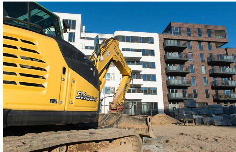
Oben: Blick von der Eduard-Duckes-Strasse Richtung Mariannenruh-Platz, August 2018. Unten: Bauarbeiten im Park 2018
