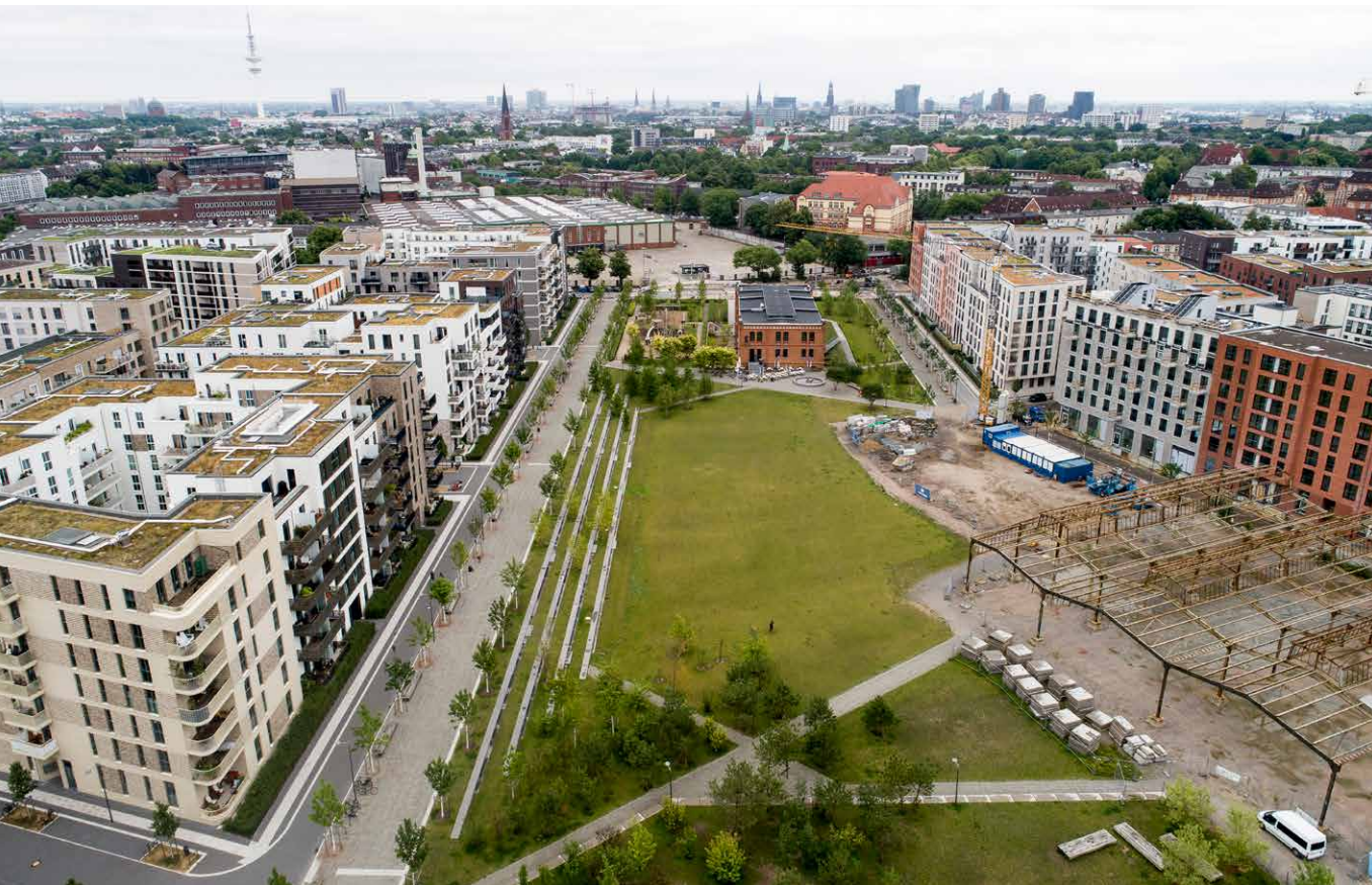
Mitte 2020: Blick Richtung Hamburger Innenstadt, der Park und das Güterhallengerüst sind noch nicht fertiggestellt.
